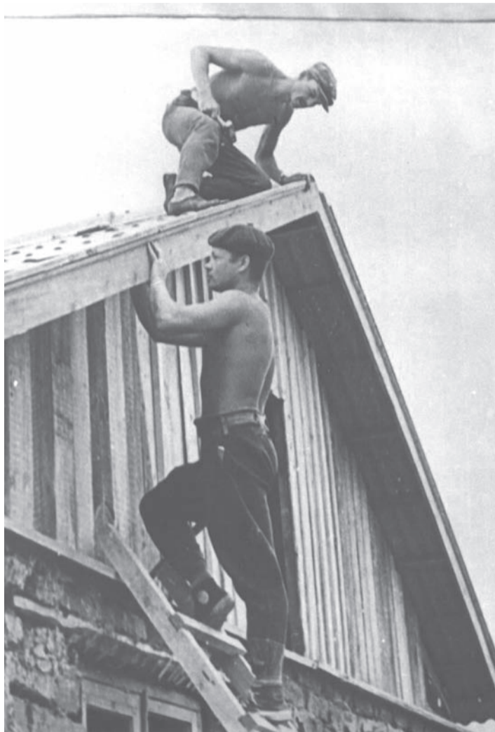
На фото: Валерий Фадеев и Анатолий Сусленков на строительстве жилого дома
